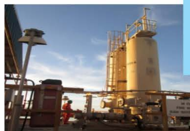
Fig. 2 Lighting Protection Installation PT Pertamina EP Subang (ITB Pertamina).
