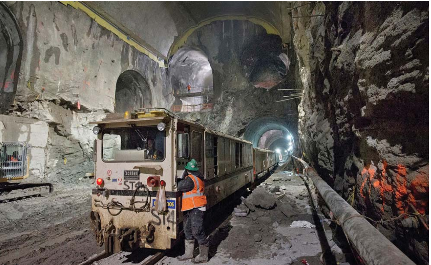
Selain dilakukan penggalian untuk jalur kereta api, pada stasiun juga dilakukan penggalian untuk akses stasiun menuju ke permukaan. Pada beberapa stasiun besar, terdapat beberapa akses stasiun untuk mempermudah jangkauan pengguna, termasuk juga akses stasiun dari beberapa area komersial.
