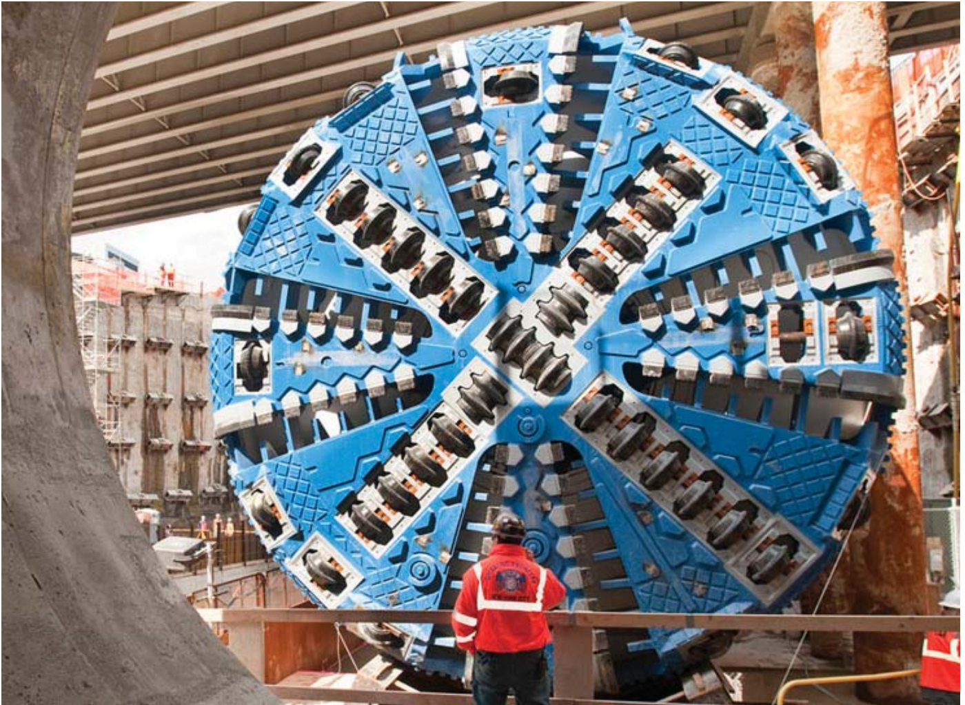
Peluncuran Tunnel Boring Machine (TBM) pada East Side Access Project. Mesin serupa juga akan didayagunakan untuk pembangunan MRT Jakarta mulai dari Al Azhar sampai dengan Bunderan HI dengan trase bawah tanah sepanjang 5.9 km.
