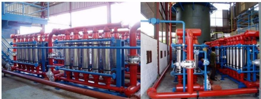
Gambar 4. Membran keramik untuk pengutipan solid dari *heavy phase decanter* di PT Agrical, Bengkulu
